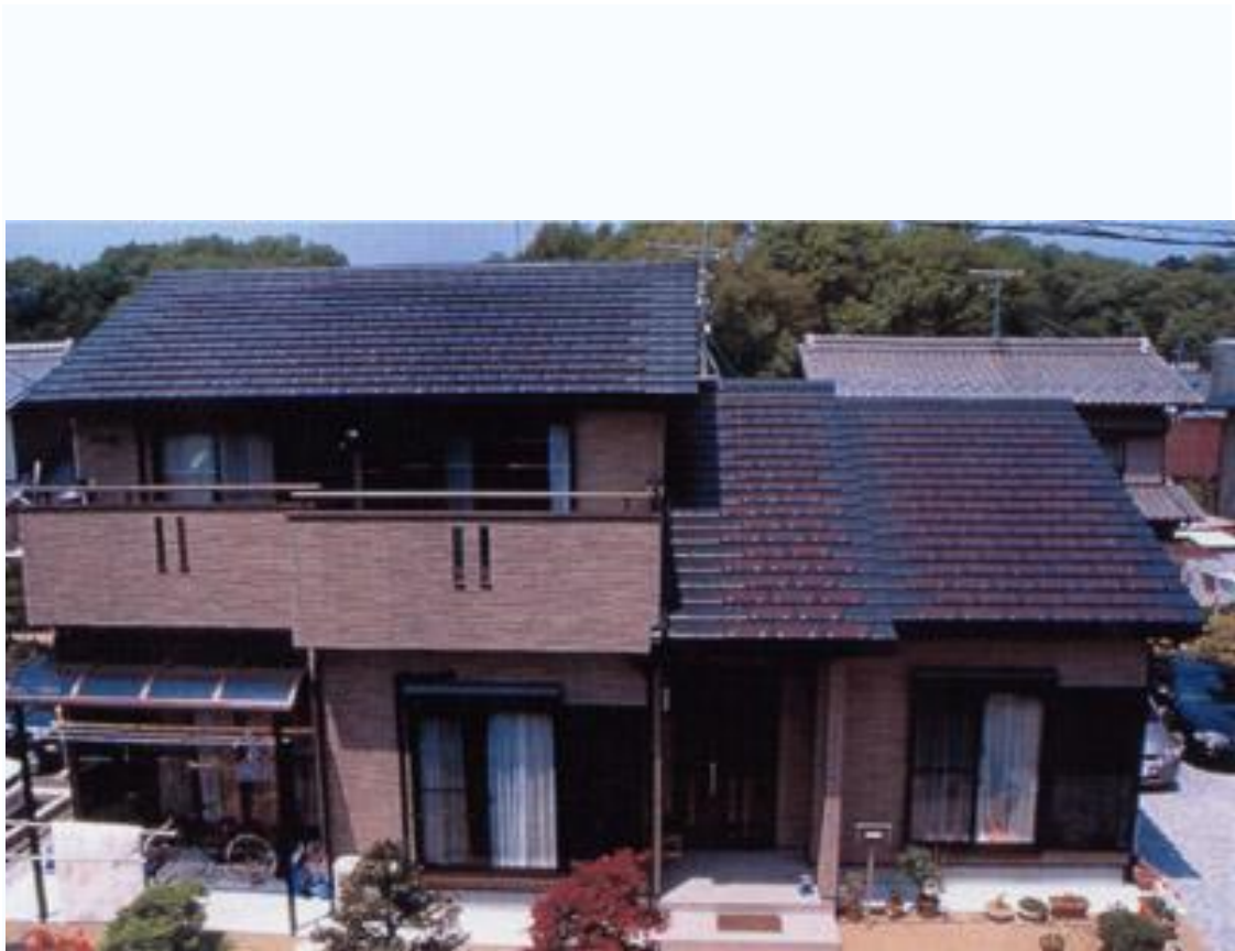
太陽能瓦屋頂
