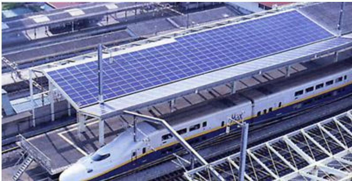
高崎太陽能車站
