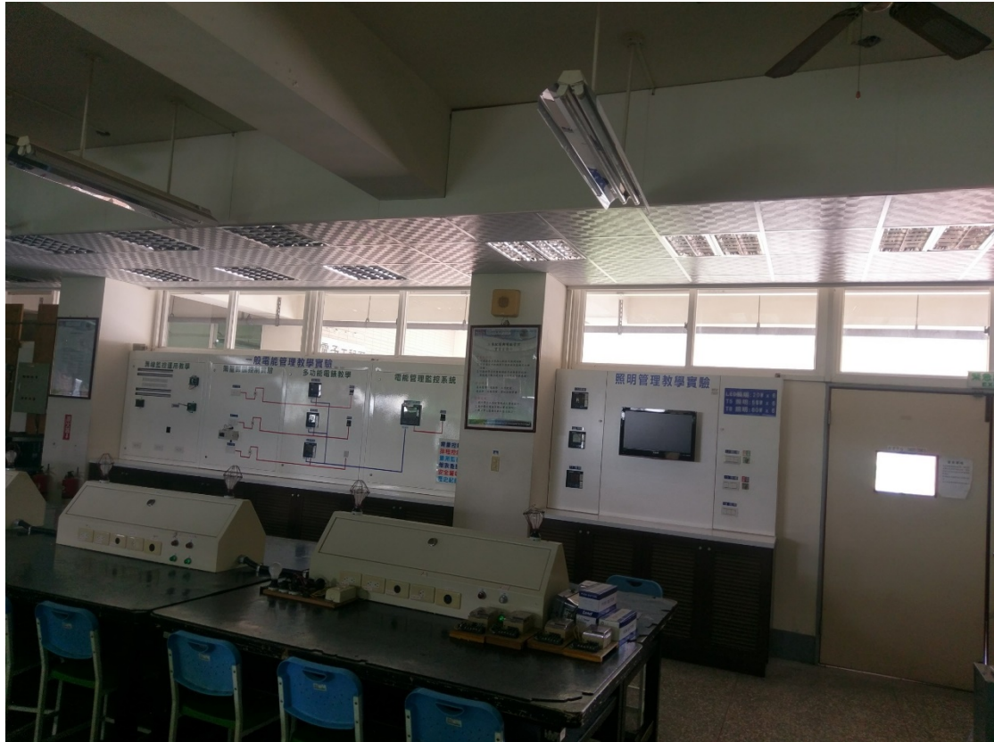
圖 3-7 修平科技大學 B320 電機實驗室
